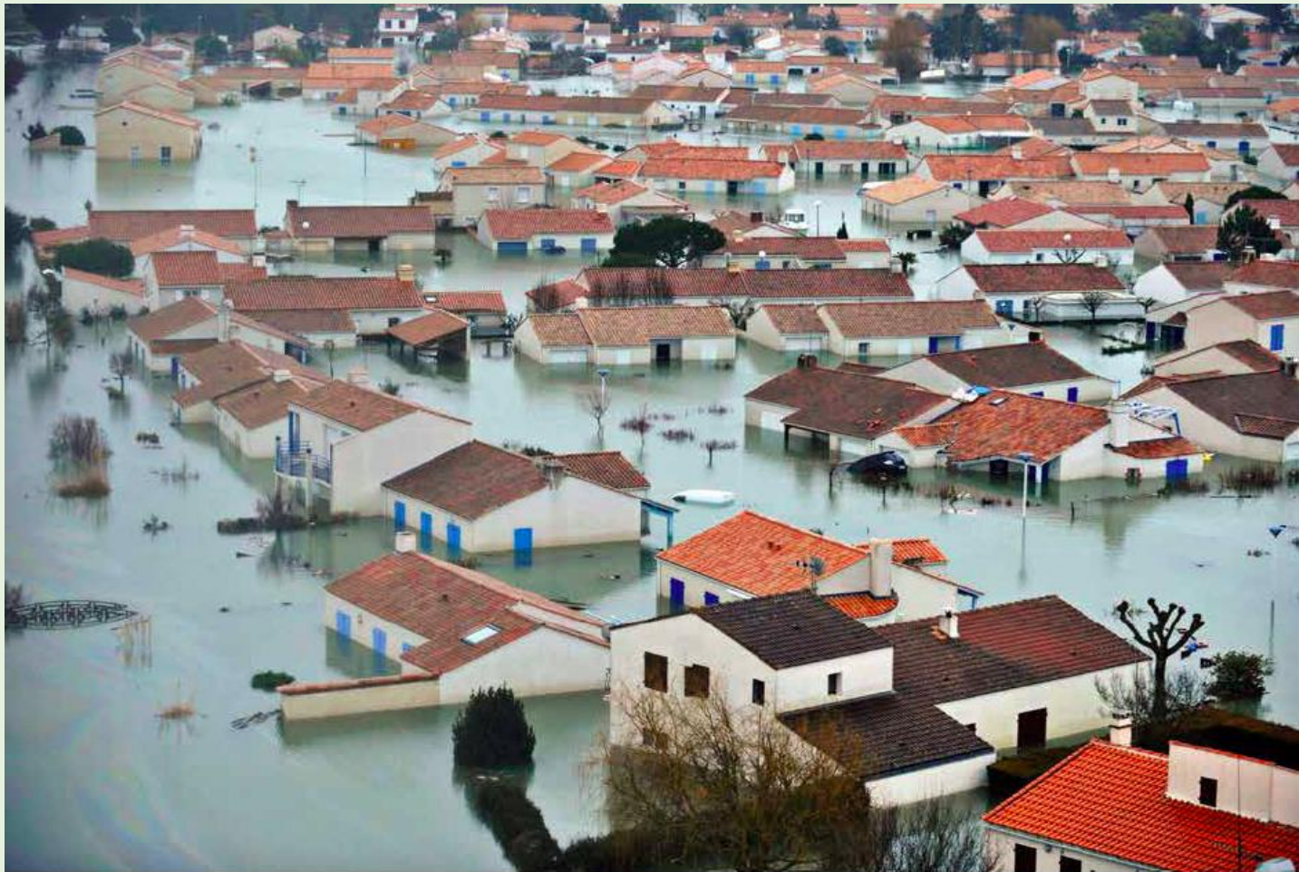
CATASTROPHE NATURELLE Dans la nuit du 27 au 28 février 2010, la tempête Xynthia frappe La Faute-sur-Mer. La mer submerge une digue. De nombreuses maisons bâties en zone inondable n'ont ni étage ni trappe au plafond permettant de s'échapper. Bilan : 29 morts.
